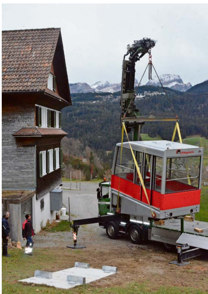
Die Kabine wird vorsichtig auf das Fundament gehoben.
